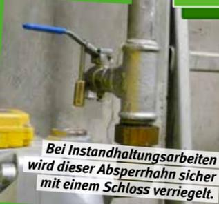
Bei Instandhaltungsarbeiten wird dieser Absperrhahn sicher mit einem Schloss verriegelt.
