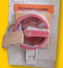
Der gesicherte Hauptschalter verhindert, dass das Band während Reparatur- oder Wartungsarbeiten irrtümlich von Kollegen wieder eingeschaltet wird.
