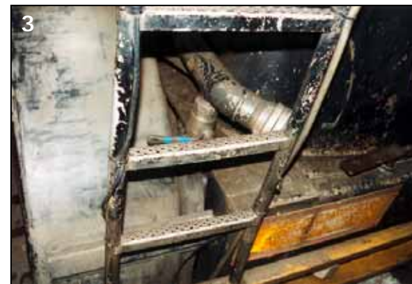
◀ Die Leiter des Siloauflegers befand sich in ordnungsgemäßem Zustand.
