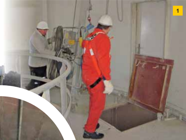
1 Arbeiten in Silos dürfen nur zu zweit ausgeführt werden. Dabei verbleibt ein Mitarbeiter als Sicherungsposten außerhalb des Silos. Erst nach Anlegen der PSA (Auffanggurt) darf die Befahrungsöffnung über der Silotasche geöffnet werden.
