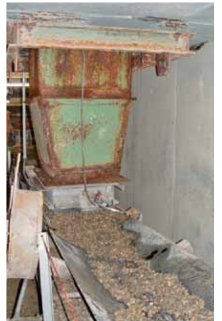
Am Auslaufrichter oberhalb des Förderbandes war ein Fuß von Hannes zu sehen. Wegen der massiven Ausführung des Stahltrichters kamen die Helfer vom Abzugstunnel aus nicht an Hannes heran.
