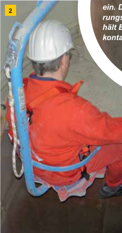
2 Verfahren Sie die Befahreinrichtung an die Öffnung. Steigen Sie in den Befahrungssitz und befestigen Sie dort den Auffanggurt. Schwenken Sie den Sitz über die Befahrungsöffnung.
