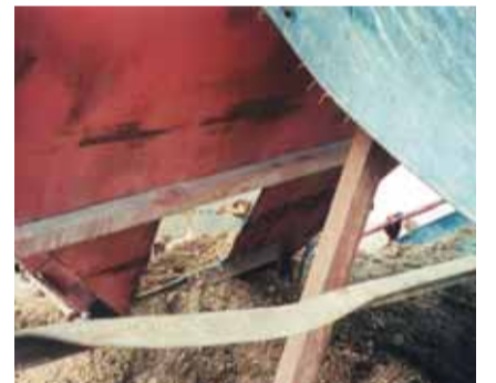
Zur Bergung des Toten musste eine Öffnung in das Silo geschnitten werden.
