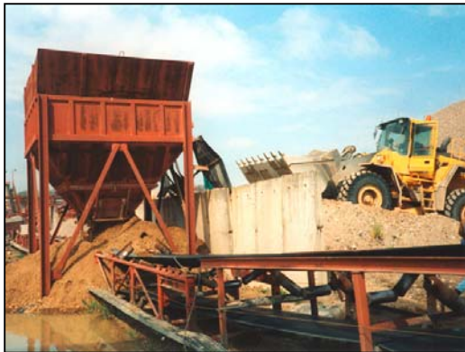
▲ An diesem Dosier-Silo sollte der Mitarbeiter Risse von außen schweißen.
