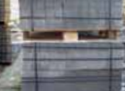
Vorsicht: unsichere Lagerung! Diese Steinpakete liegen nicht bündig über den Holzpaletten. Das obere Holzbrett könnte jederzeit brechen, was zum Umstürzen des gesamten Stapels führen würde.
