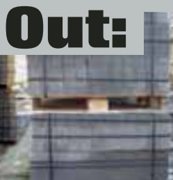
Vorsicht: unsichere Lagerung! Diese Steinpakete liegen nicht bündig über den Holzpaletten. Das obere Holzbrett könnte jederzeit brechen, was zum Umstürzen des gesamten Stapels führen würde.
