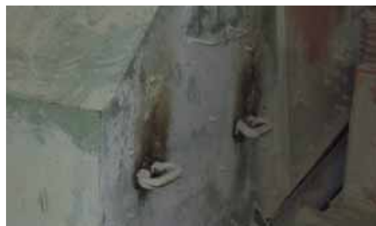
Die Halteösen wurden nachträglich um 90 Grad gedreht. Hier ist ein sicheres Einhängen möglich.
