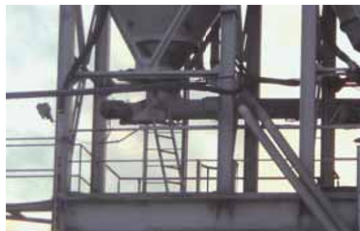
Silo und Leitstand waren fast 50 m voneinander entfernt. Sichtkontakt bestand nur unzureichend.
