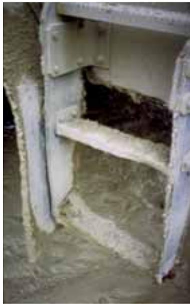
▲ *An verschmutzten oder verbogenen Aufstiegen lässt sich's leicht aus- oder abrutschen.*
