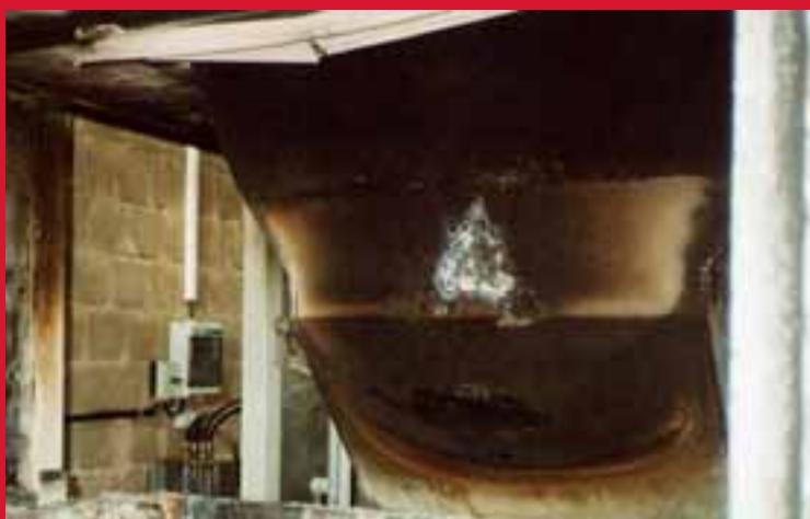
Hier brach das Feuer aus. Links ist noch die Halterung des Schalölbehälters zu sehen.
