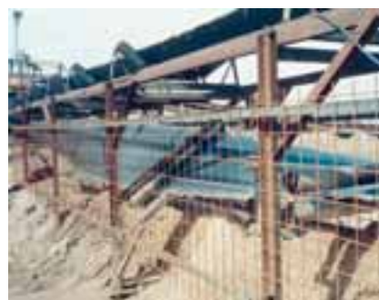
Das neu installierte Sicherungsgitter.
