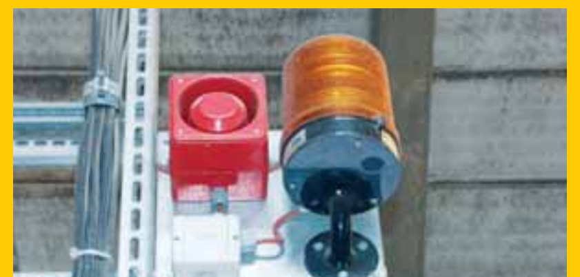
Mittels einer Anlaufwarneinrichtung werden die am Band befindlichen Kollegen gewarnt.
