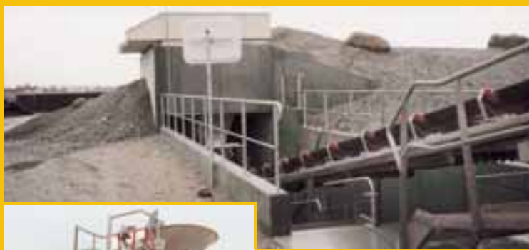
Aufgabetrichter an einer Kiesaufbereitung: Rutschfeste Wege mit sicherem Handlauf. Und der Clou: Mit einer Spiegelhilfe kann der Fahrer den rückwärtigen Überlaufbereich einsehen.
