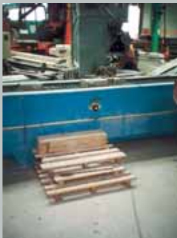
Wo keine Übergänge vorhanden sind, schafft man sich kurzerhand welche. Doch dieses Provisorium sollte dringend durch eine sichere Treppe ersetzt werden.
