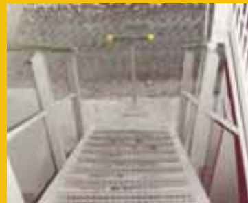
Diese Treppe führt direkt auf einen Verkehrsweg zu. Ein auffälliger „Stopper“ verhindert, dass Mitarbeiter blindlings auf die Strecke laufen und mit LKWs Bekanntschaft schließen.
