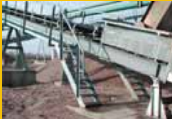
Dieser Laufsteg endet an einer robusten Treppe mit Geländer – Verletzungsgefahren durch die Überwindung großer Höhenunterschiede ausgeschlossen.
