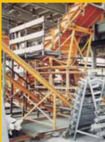
Treppenschalung, die nachträglich mit einem Arbeitspodest nachgerüstet wurde – eine effektive und kostengünstige Absturzsicherung.
