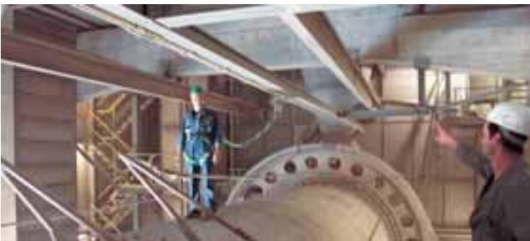
Mit so viel Sicherheit im Rücken lässt es sich gut arbeiten.
