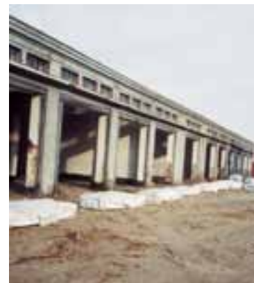
Dieser alte Garagenkomplex sollte abgerissen werden.
