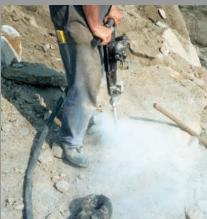
Ohne Absaugglocke staubt's in alle Richtungen.
