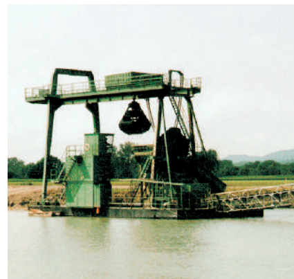
Die Schwimmbaggeranlage in der Winfried H. arbeitet.
