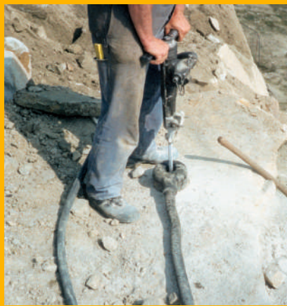
Mit Absaugglocke wird der Staub beim Bohren nicht frei.
