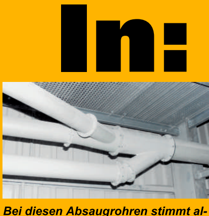
Bei diesen Absaugrohren stimmt alles: der Durchmesser, schlanke Übergänge, die Verjüngung.
