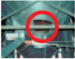
Aus dieser Siloöffnung konnte Max gerettet werden.
