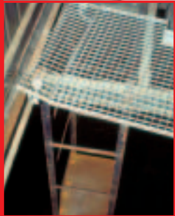
Die eingehängte Arbeitsbühne
