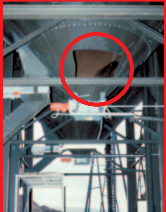
Durch die Rettungsöffnung im Silo-kegel wurde „Maxe“ rausgeholt.
