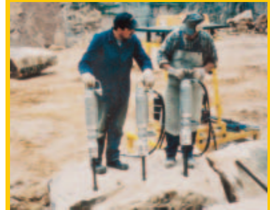
Nachgestellt: Mit handgeführten Hydraulikbohrern geht's zur Sache.
