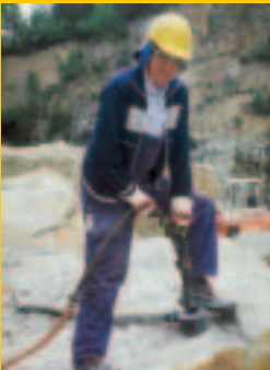
Dieser Kollege ist optimal ausgerüstet mit Schutzbrille, Gehörschutz-Schutzkleidung, Helm und Absaugvorrichtung.
