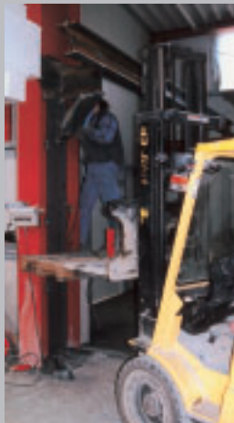
Out: Eine Staplerpalette ist kein geeigneter Höhenarbeitsplatz!
