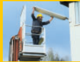
In: Geeignete und sicher befestigte Arbeitsbühne.
