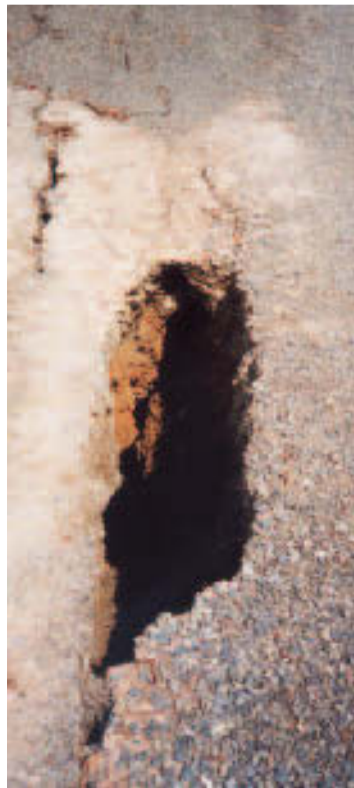
Marc K. übersah diese 5 m tiefe Erdspalte
