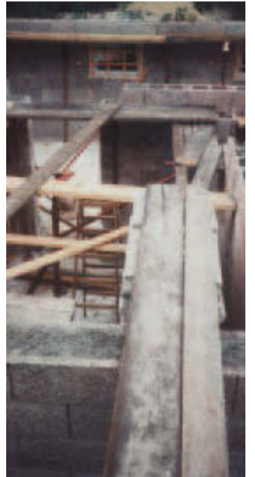
Wie eine Drahtseilnummer im Zirkus. Robert A. arbeitet als Betonpumpenmaschinist oft ohne Absturzsicherung.
