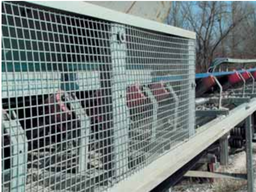
Sicherung der Einzugsstellen an Tragrollen mit durchgriffsicheren Gittern
